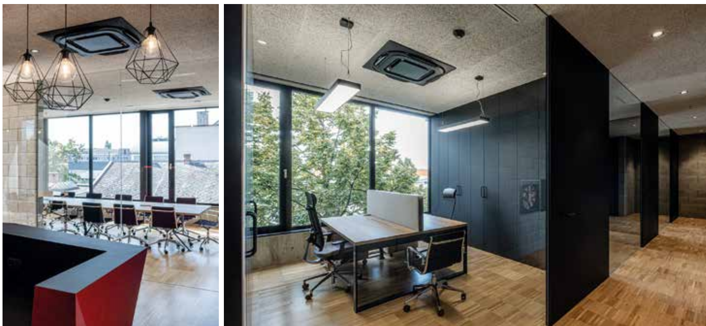
Vnitřní stropní kazetové jednotky s kruhovým výdechem a dekorativním panelem v černé barvě
