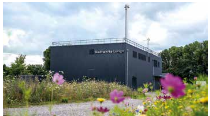
Tato teplárna v německém městě Lemgo umožňuje ekologičtější zásobování historického města teplem. (Foto: GEA/Tim Luhmann)
