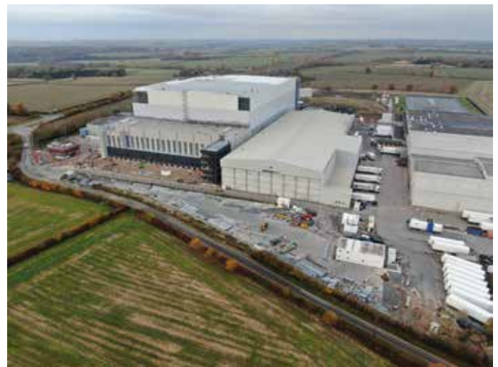
Společnost Magnavale, jeden z předních britských poskytovatelů chladírenských skladů, staví v Easton Lincolnshire ve východní Anglii 47 metrů vysoký chladírenský sklad s kapacitou 101 000 palet. Zařízení bude plně automatizované a bude využívat 100 % obnovitelné energie (Foto: Magnavale)
