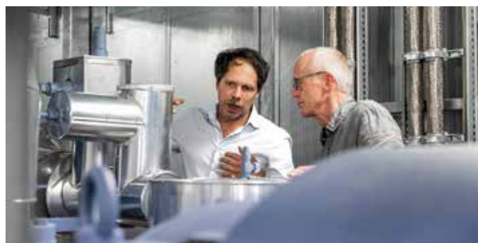
Thomas Lergenmüller (vlevo), produktový manažer pro tepelná čerpadla, GEA Heating and Refrigeration Technologies, a Uwe Weber (vpravo), vedoucí oddělení výroby elektřiny a tepla, Stadtwerke Lemgo GmbH (Foto: GRA/Tim Luhmann)
